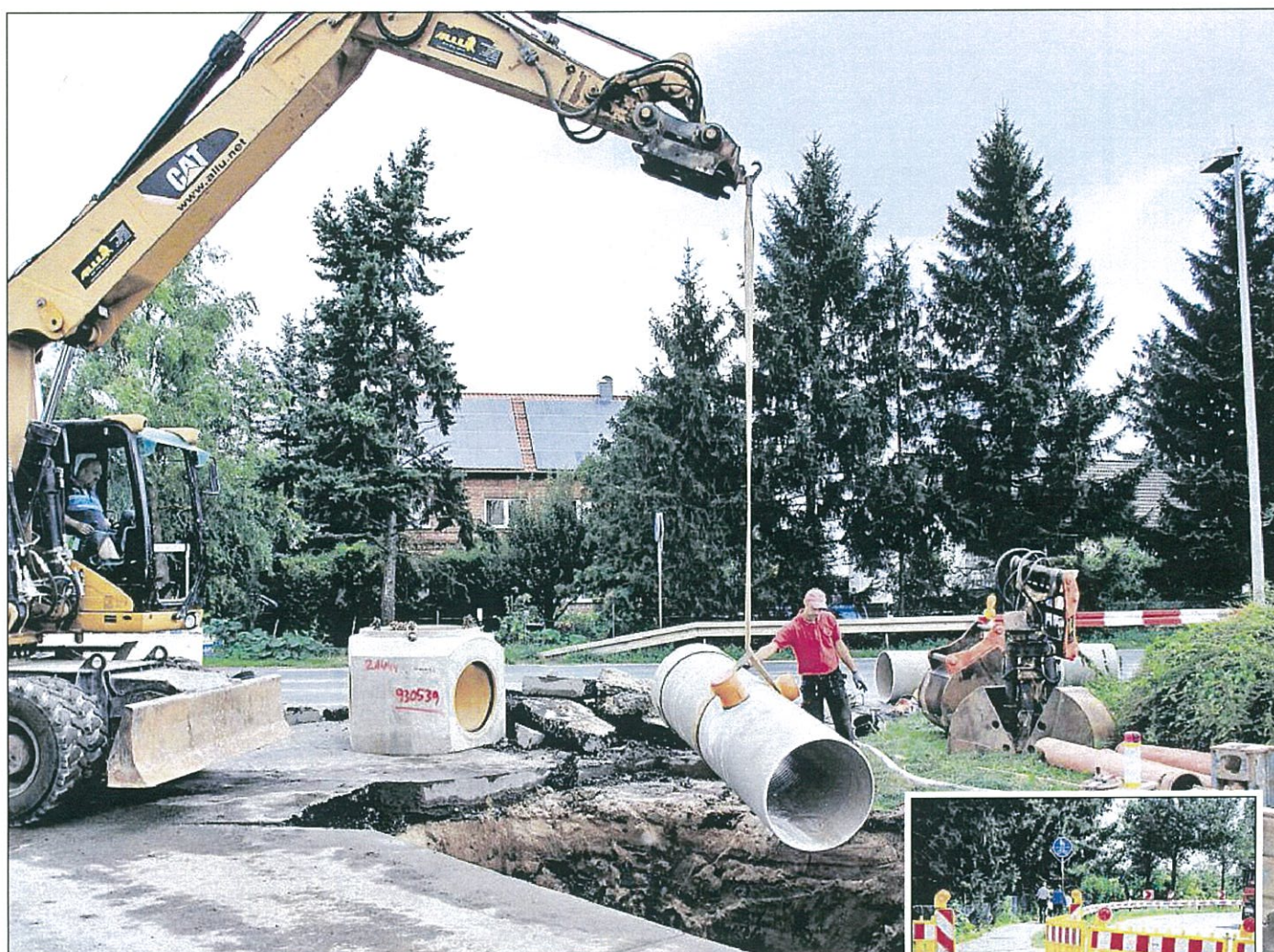
Wegen Arbeiten am Kanalsystem ist die Bundesstraße 65 bei Evern zurzeit voll gesperrt. Die Umleitung nach Haimar führt über Dolgen. Brämer (2)
