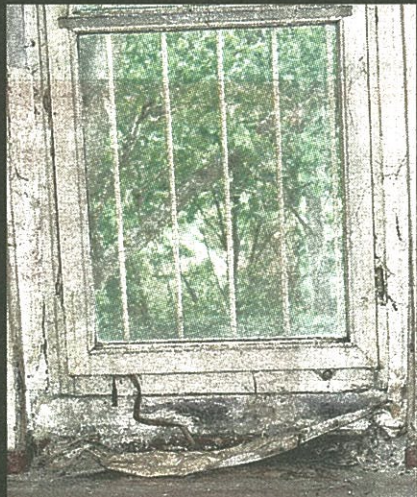
Total versifft. Schimmel frisst sich durch marodes Holz, eine Brutstätte für Krankheiten.
