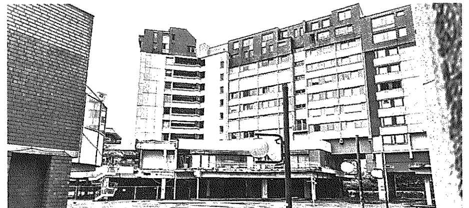
Das Problem liegt unten: Während die Wohnungen im Ihme-Zentrum weitgehend in
